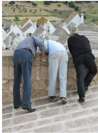
Inspectie kerkdak Locorotondo
